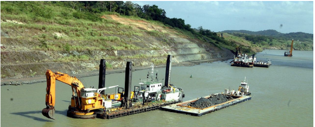
El exceso de sedimentos necesita ser dragado regularmente para asegurar el funcionamiento adecuado del Canal de Panamá.
