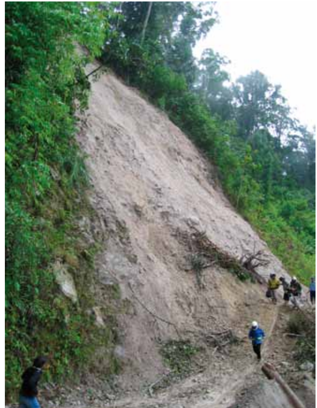
Deforestasi dan degradasi hutan dapat menurunkan kestabilan tanah pada lereng-lereng yang curam. Longsor menghalangi jalan setapak yang ada di Sulawesi Tengah.
